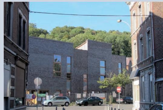
*Le projet des Z'urbains à Liège (en cours de construction) vise le standard basse énergie également grâce à l'isolation renforcée des parois et à la mitoyenneté.*
