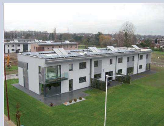
*Les logements du quartier des Pléiades à Visé ont des besoins de chauffage inférieurs à 30 kWh/m<sup>2</sup>.an. Des sources d'énergies renouvelables sont mobilisées pour la production de chaleur du quartier : chaudière biomasse à pellets et capteurs solaires thermiques, ce qui permet d'atteindre l'autonomie en été.*
