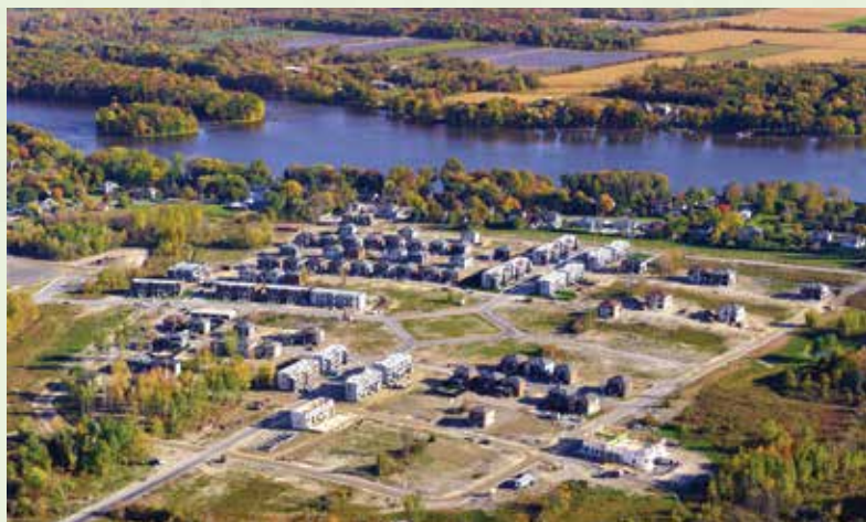
Vue aérienne pendant la construction du quartier Urbanova à Terrebonne (Qc) (Source: Ville de Terrebonne)
