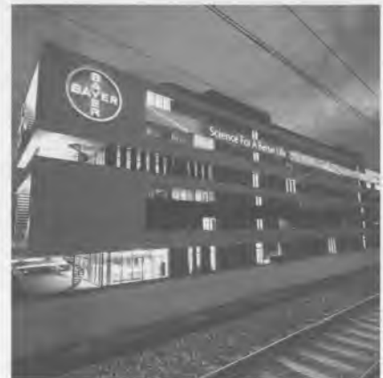
Le bâtiment EcoCommercial de Bayer MaterialScience, à Diegem en Belgique.
