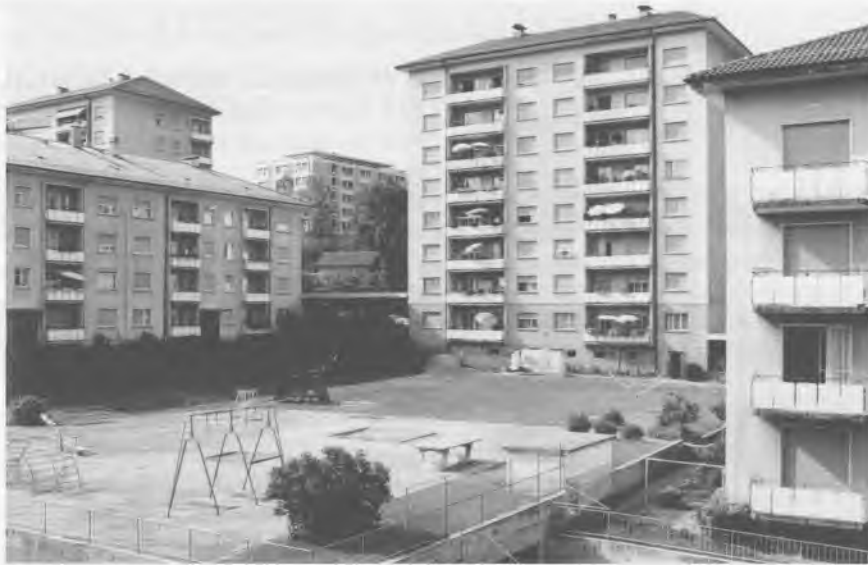
De grands espaces de loisirs entre les immeubles, avant leur rénovation extérieure
