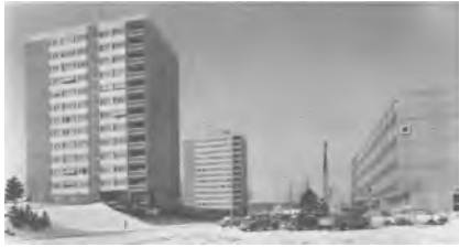
Beaumont 1 et 5 — Les travaux continuent malgré la neige
