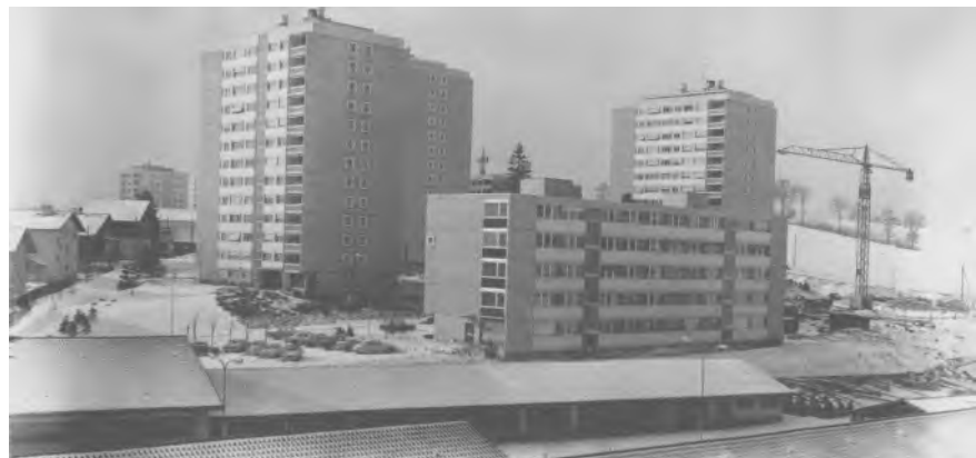
Beaumont 14-18 en construction
