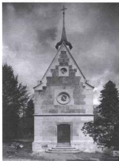
La face ouest de la chapelle.
