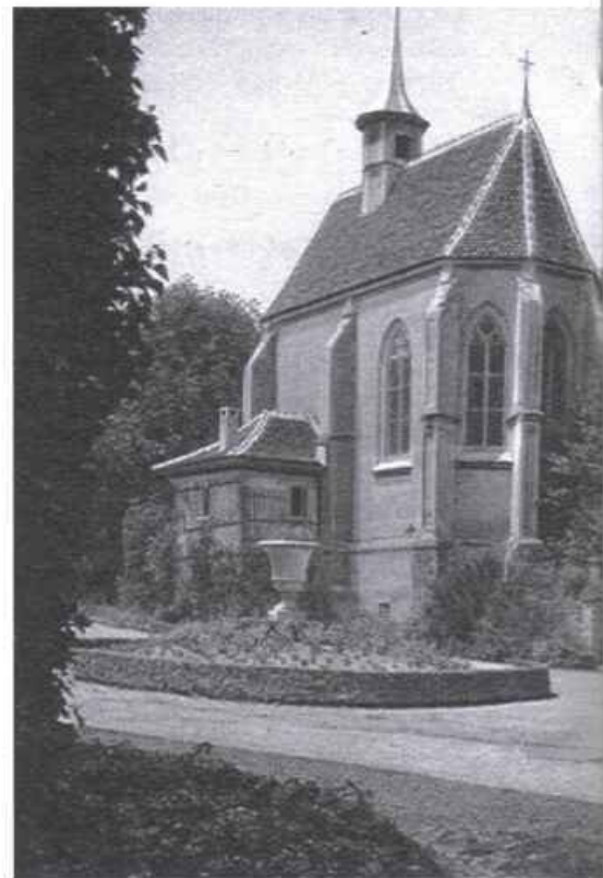
La chapelle de Pérolles avec, sur son flanc sud, la sacristie.
